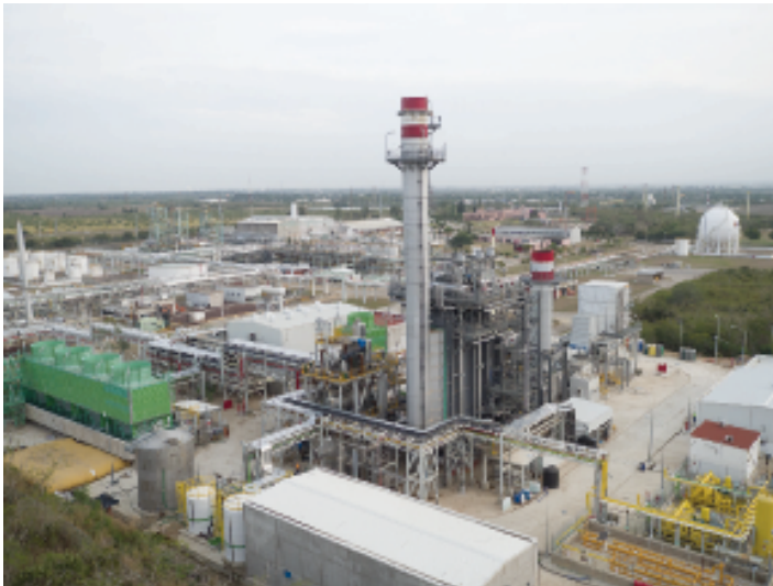
Proyecto EPC de Planta de Cogeneración para producción de vapor y generación de electricidad utilizando gas natural como combustible, construido por Tamoin en Altamira (México).
